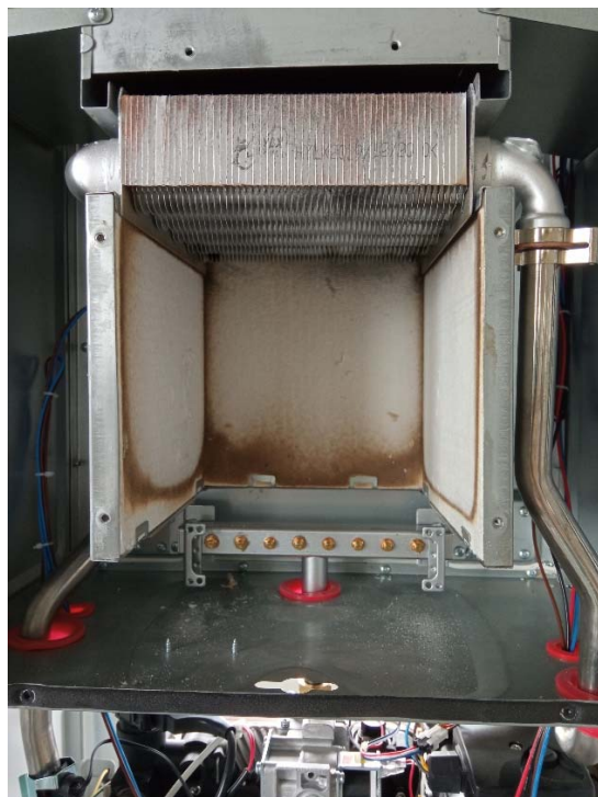
Рис. 1 Основной медный теплообменник и камера сгорания с крышкой
