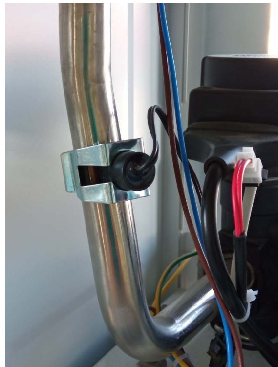
Рис. 14 Датчик температуры отопления
