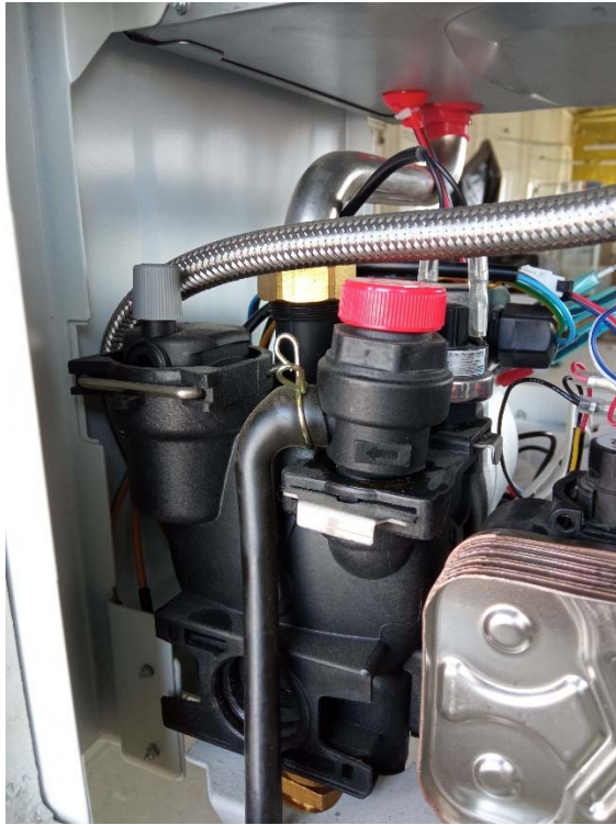
Рис.11 Входной гидроблок, включающий в себя автоматический воздухоотводчик, предохранительный клапан, датчик мин. давления теплоносителя, датчик Холла с турбиной (расхода ГВС), кран подпитки и сливной кран
