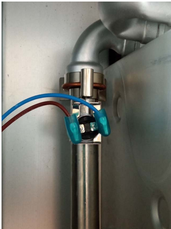
Рис. 13 Термостат перегрева
