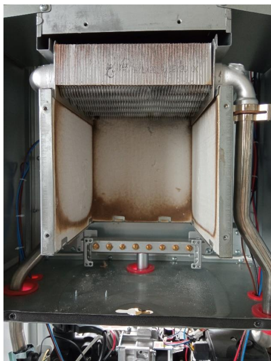
Рис.1 Основной медный теплообменник, Рис.2 Вторичный пластинчатый теплообменник камера сгорания с крышкой и теплоизоляцией ГВС из нержавеющей стали
