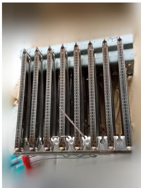
Рис.10 Газовая горелка с щелевыми насадками (ламелями), 2-мя электродами розжига и электродом контроля пламени
