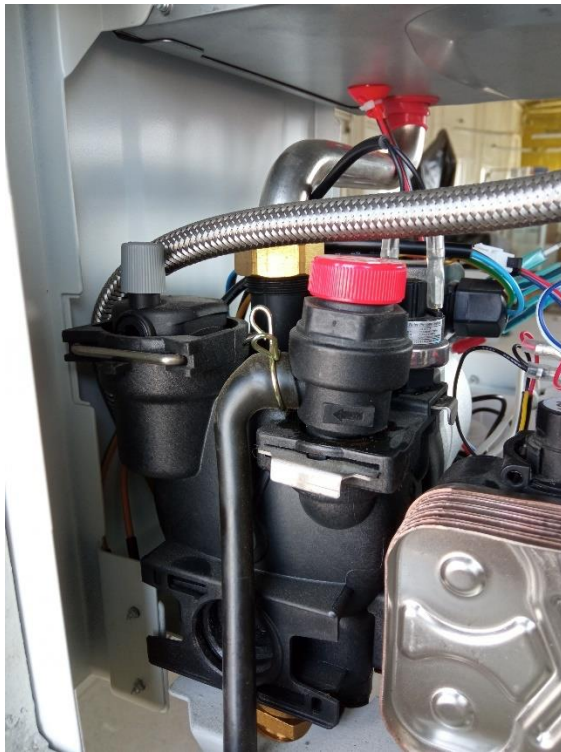
Рис.11 Входной гидроблок, включающий в себя автоматический воздухоотводчик, предохранительный клапан, датчик минимального давления теплоносителя, датчик Холла с турбиной (расхода ГВС), кран подпитки и сливной кран
